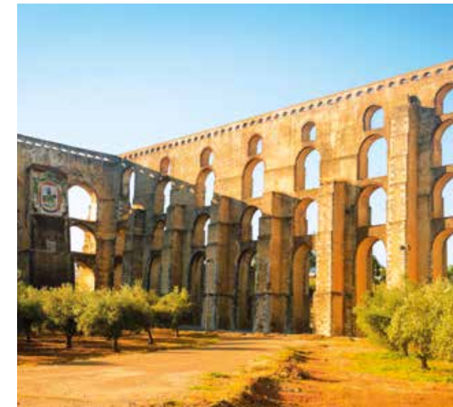
Acueducto de Amoreira · Elvas
